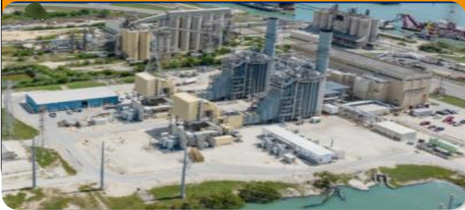
Nueces Bay NGCC – 635 MW
